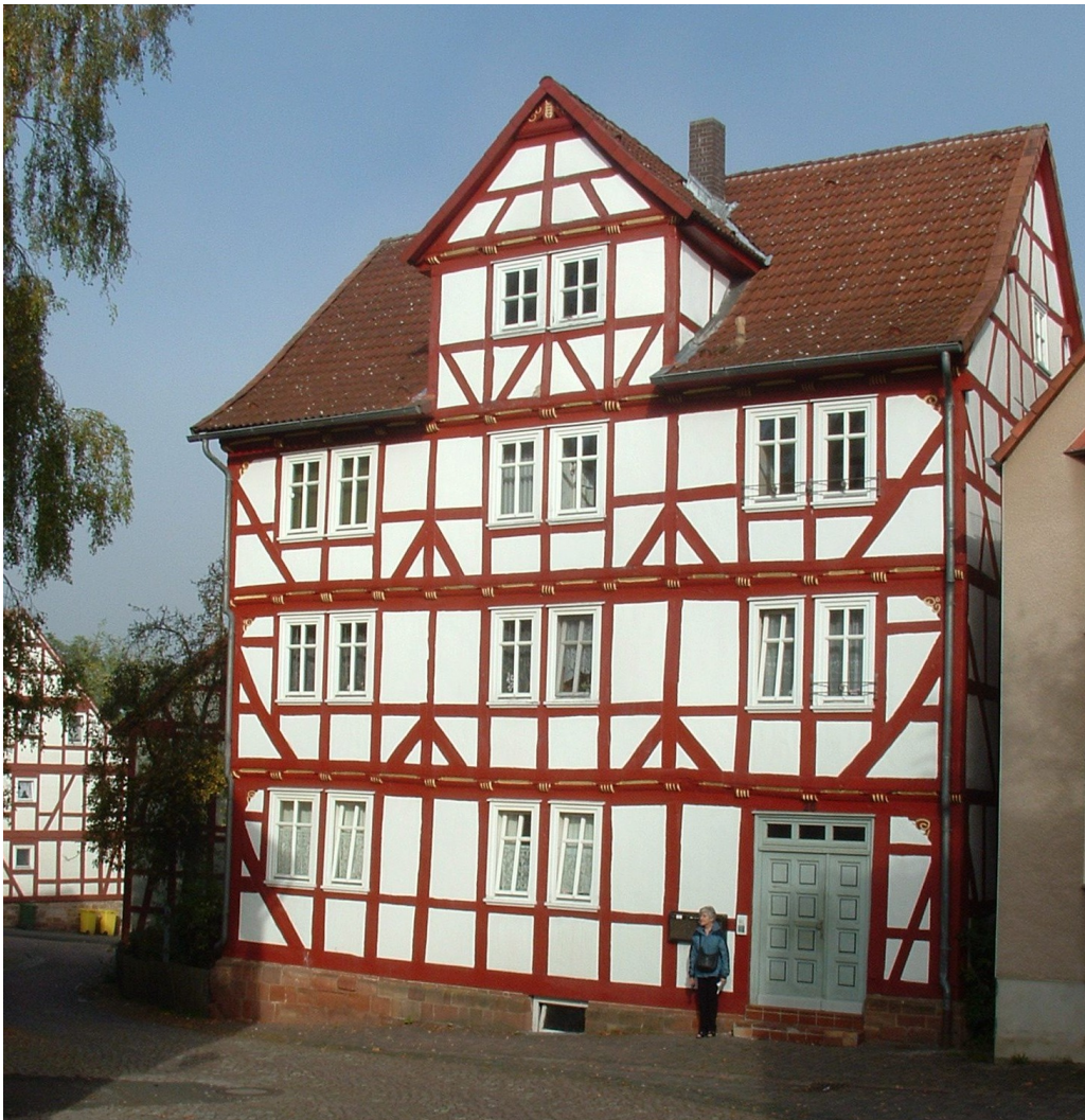
2010.10.09: Marx - Katzenstein house, Frankenberg
